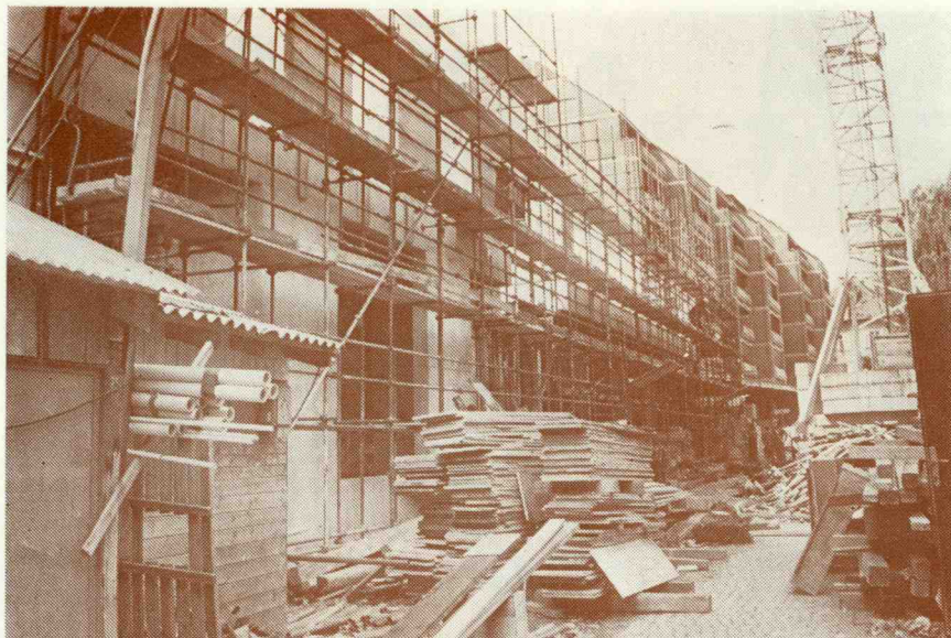
Pogled s severovzhoda in iz Slovenske ulice na gradbišče — v ozadju Gradisov stanovanjsko poslovni blok
